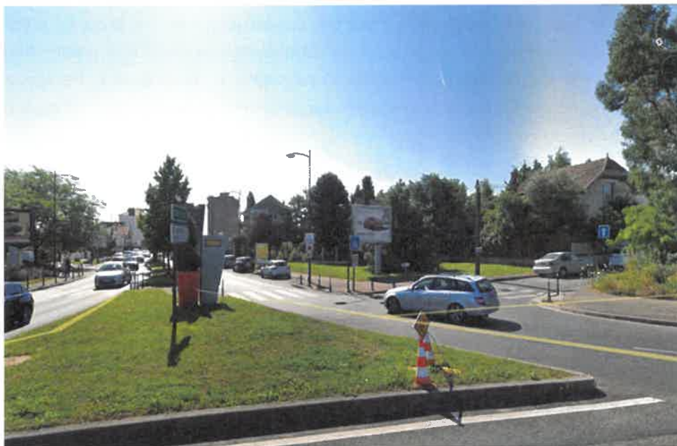
Sortie du BIP en direction du centre-ville via la RD 14 boulevard Pasteur en direction d'Épinay sur seine
